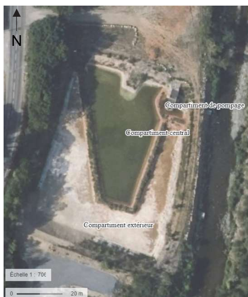
Illustration 120 : Lagune d'infiltration après travaux de compartimentage (été 2022).
