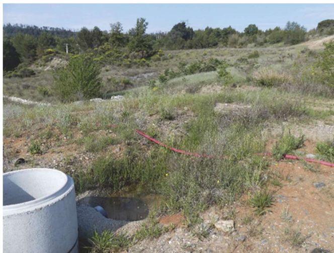
Illustration 93 : Avoir bétonné de la source Arsine (mai 2022).
