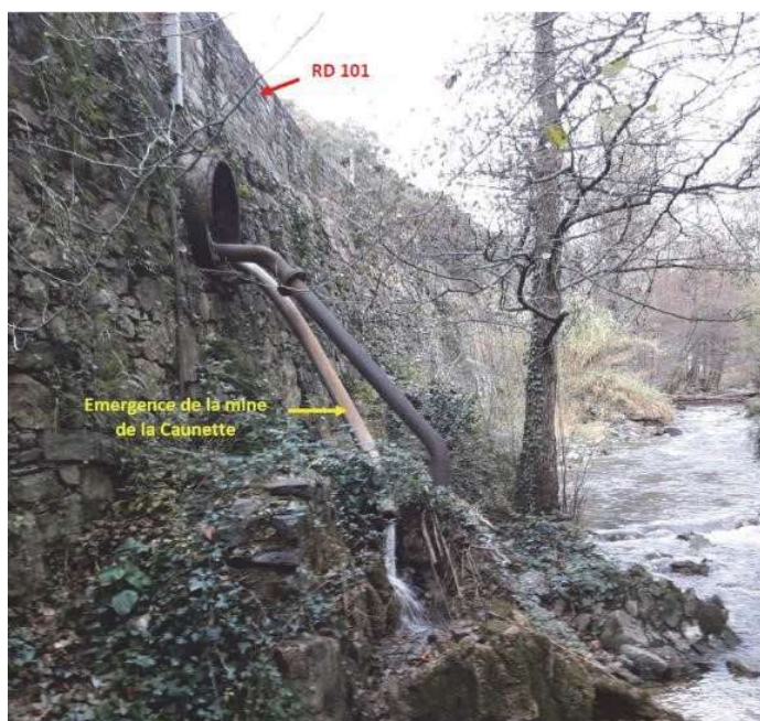
Illustration 109 : Emergence du réservoir minier de la mine de la Caunette (©MINELIS, 2020).
