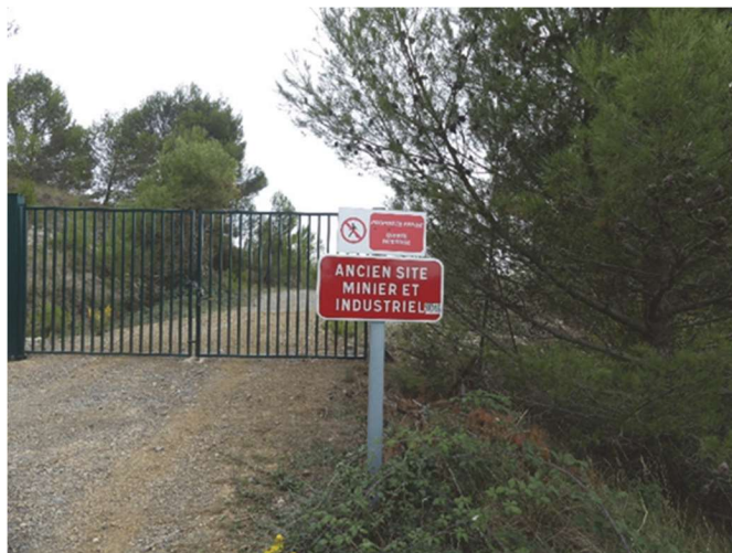
Illustration 8 : Réparation du portail et renforcement de la signalétique.
