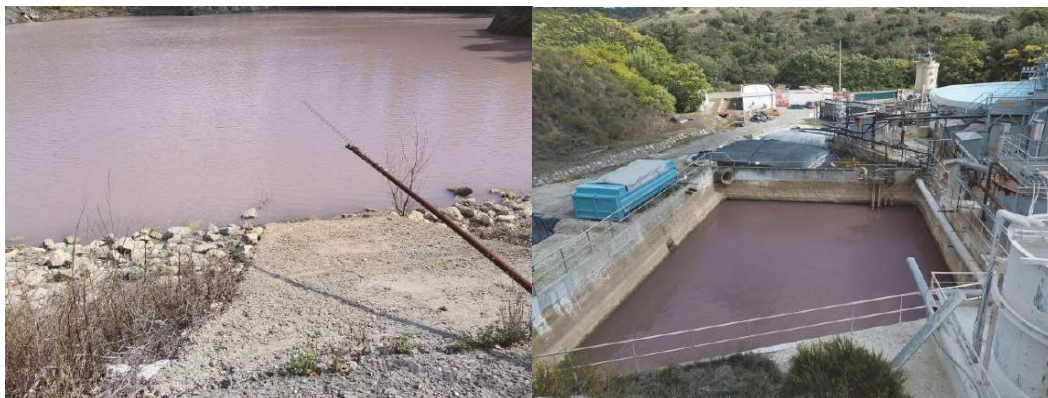
Illustration 121 : Coloration des eaux du B6 (à gauche) et dans le bassin usine (à droite) - 27 Septembre 2022.
